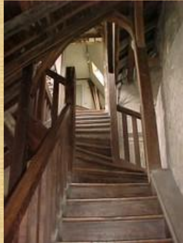
Escalier sur cour
