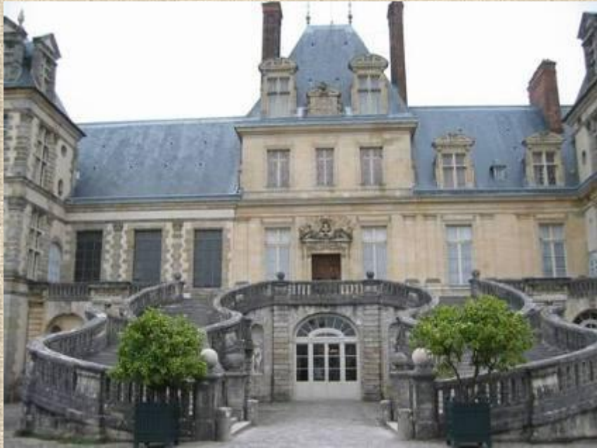
Entrée du château de Fontainebleau
